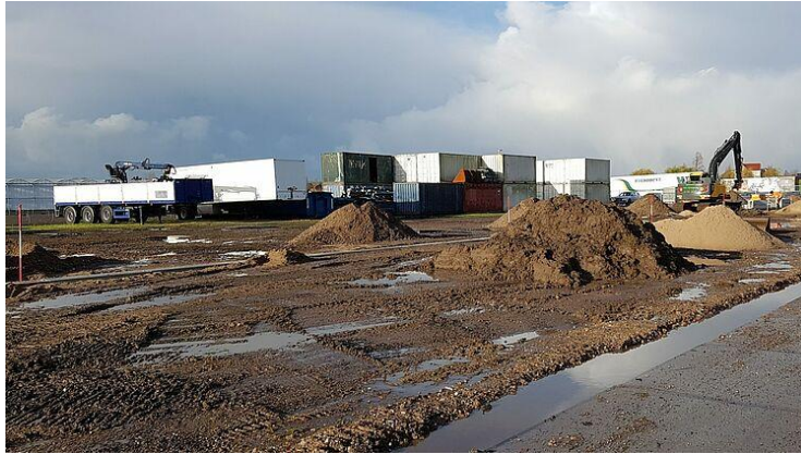
Het nieuwe stibosplein in aanleg, foto: Greenport Boskoop.
